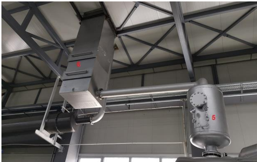
Слика II-11. Примарен и секундарен филтер на врела смеса од пиролитички гасови
