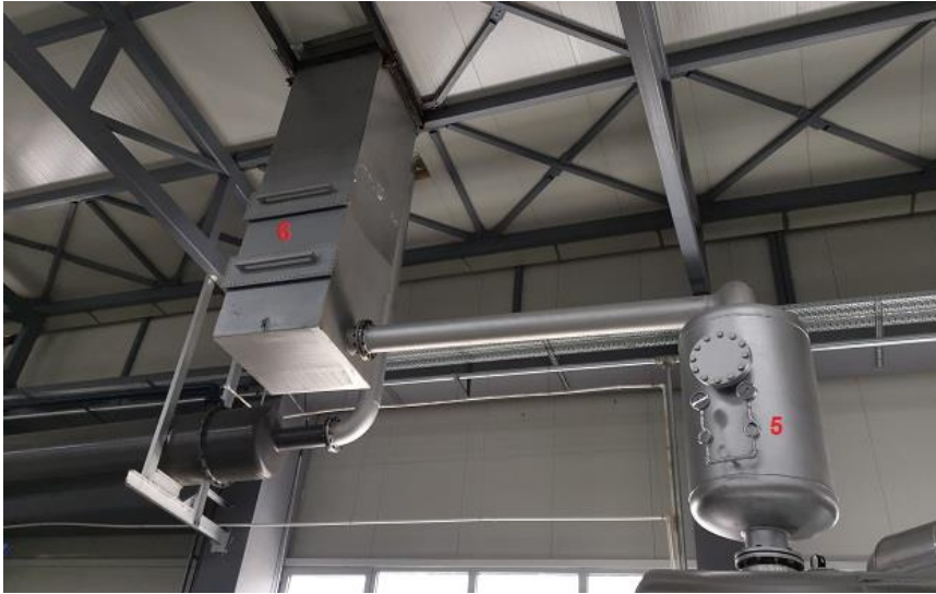
Слика VIII-1. Примарен и секундарен филтер на врела смеса од пиролитички гасови
