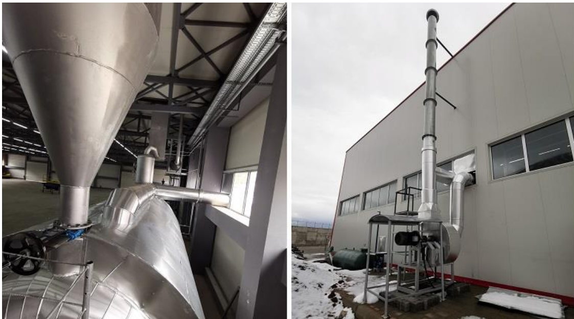
Слика VIII-3. Систем за извлекување на излезните гасови со циркуларна пумпа и оџак
