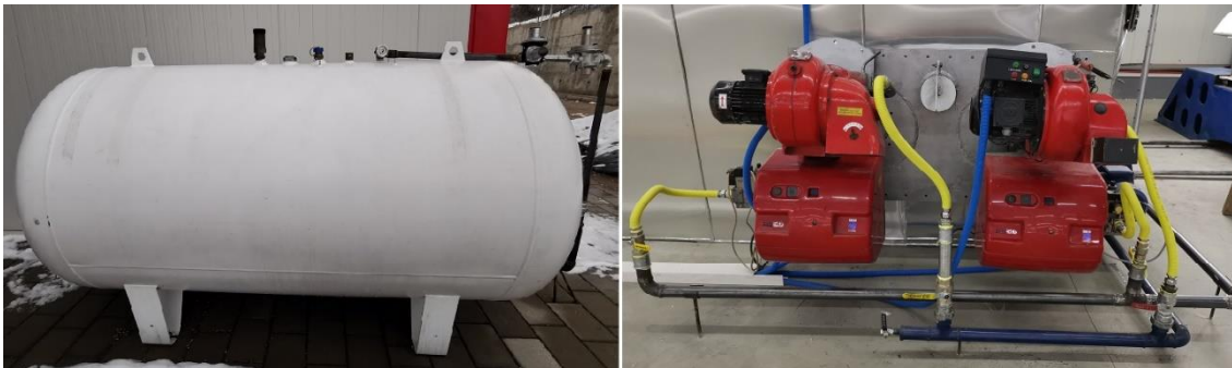
Слика II-9. Резервоар за ТНГ и горилници од комора за согорување
