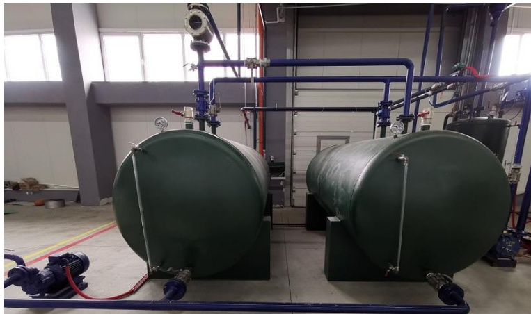
Слика II-14. Собирни резервоари за пиролитичко масло
