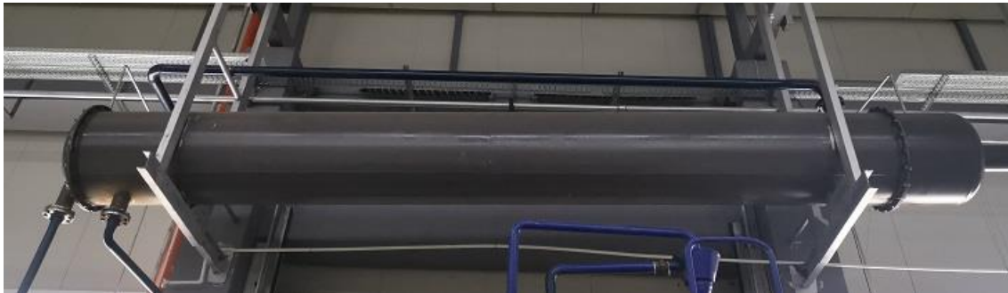
Слика VIII-2. Изменувач на топлина (кондензатор)
