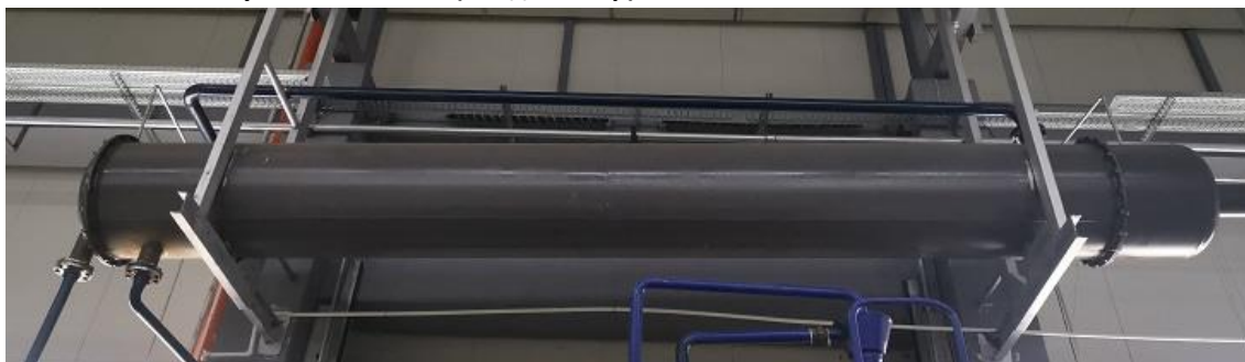
Слика II-12. Изменувач на топлина (кондензатор)
