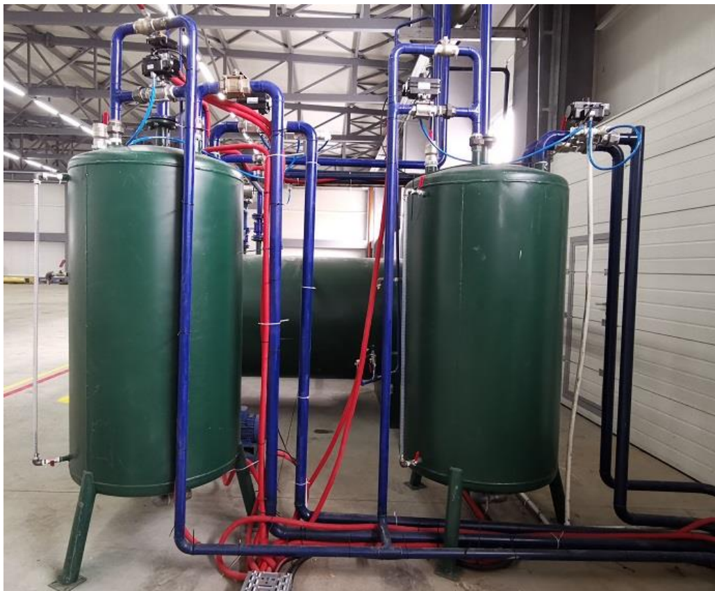
Слика II-15. Балансен и вакуум резервоар за пиролитички гас
