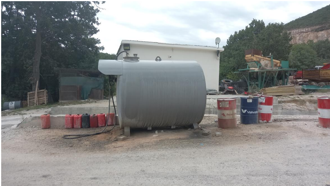
Слика 4. Резервоар со пумпа за гориво
