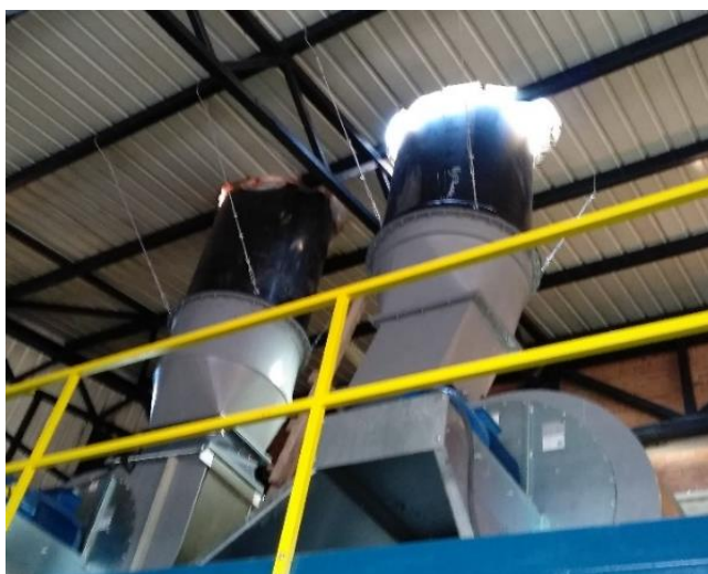
Слика 34 Изглед на двата филтри CMMV 630 во DC Формација
