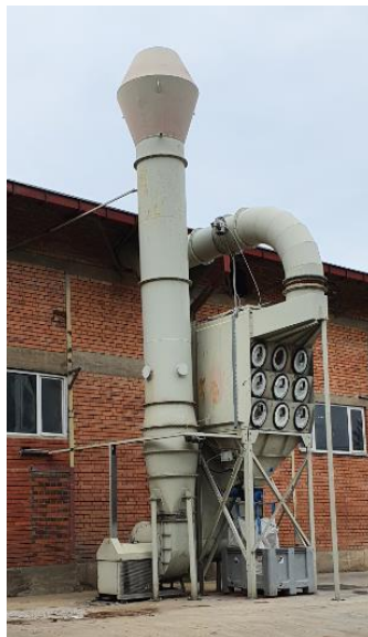
Слика 12 Филтер на монтажна линија за индустриски батерии
