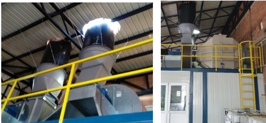
Слика 13 Изглед на двата филтри CMMV 630 во DC Формација
