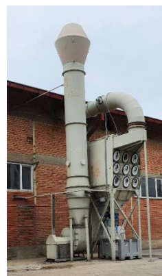
Слика 33 Филтер на монтажна линија за индустриски батерии
