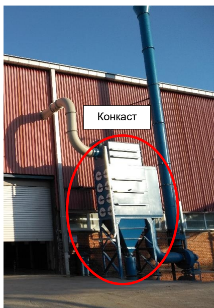
Слика 29 Филтер на машина за производство на мрежа на starter решетки (Concast)
