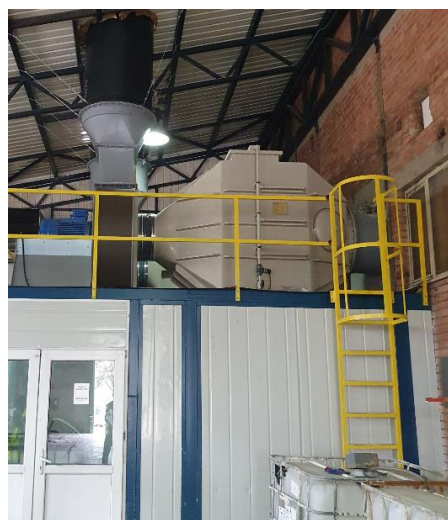
Слика 34 Изглед на двата филтри CMMV 630 во DC Формација
