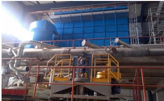
Слика 14 Систем на цевководи за одведување на димните гасови од секоја печка во циклонот и филтерот INTENSIV
