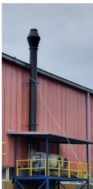
Слика 31 Филтер на MF машини за лепење на капак
