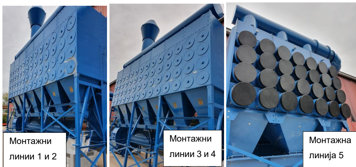
Слика 27 Филтер на монтажни линии 1-5
