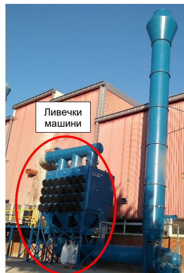
Слика 28 Филтер на машини за лиење на полови изводи, ситни делови, прачки, Хади1 - 3, ТБС 1-4
