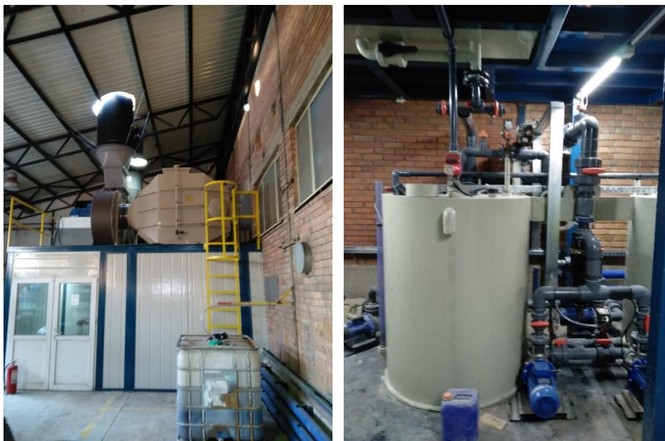
Слика 3 Систем за неутрализација на водите од ДЦ формација
