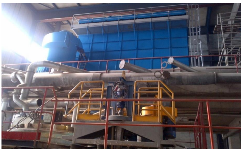
Слика 35 Систем на цевководи за одведување на димните гасови од секоја печка во циклонот и филтерот INTENSIV
