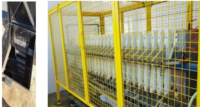
Слика 17 Егализационен резервоар (лево), комора на филтер преса (десно)
