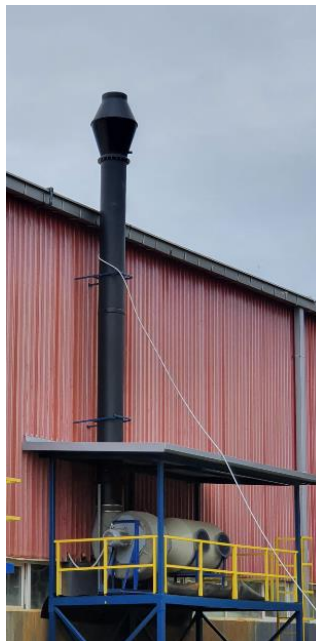
Слика 10 Филтер на MF машини за лепење на капак
