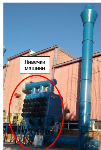
Слика 6 Филтер на машини за лиење на полови изводи, ситни делови, прачки, Хади1 - 3, ТБС 1-4
