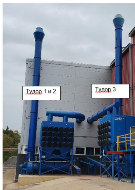
Слика 4 Филтер на машините за полнење на вреќички Тудор 1-3
