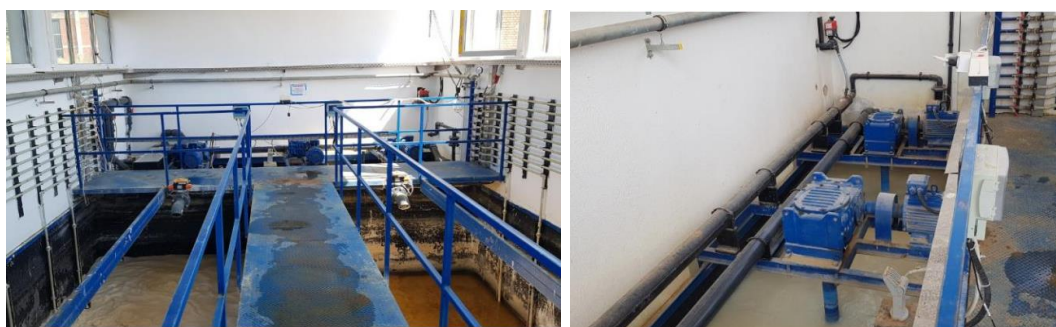
Слика 37 Станица за третман на отпадни води - базен за неутрализација и мешалките во резервоарот
