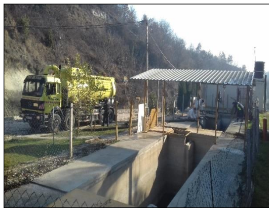
Слика бр. II-23: Вадење талог од резервоар
