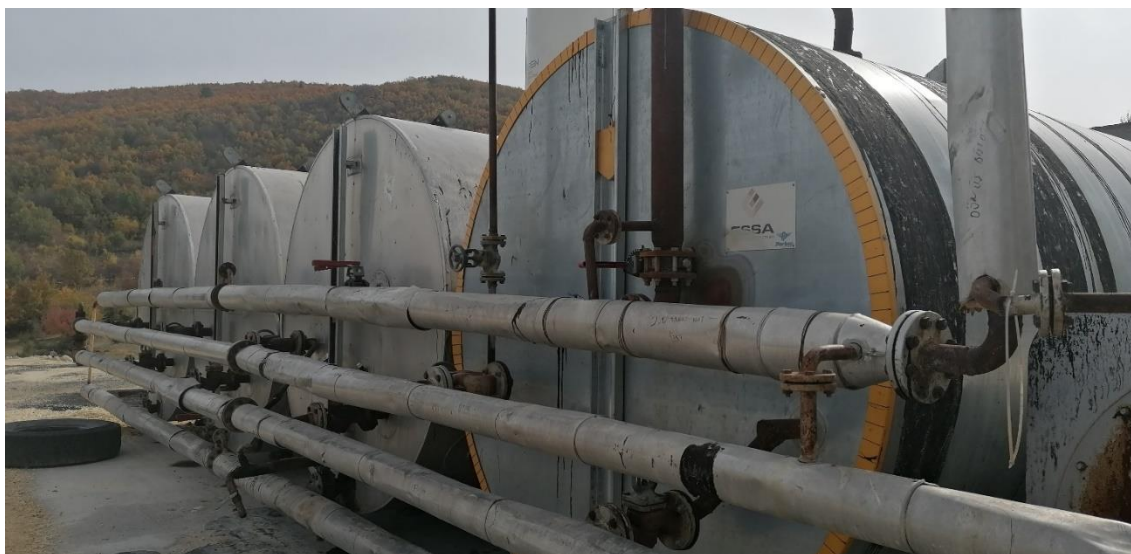
Слика- Резервоари за складирање на битумен
