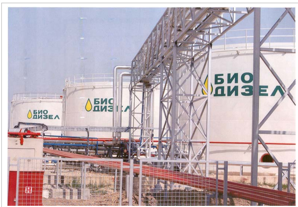
Слика бр.V.1-1: Надземни резервоари за биодизел
