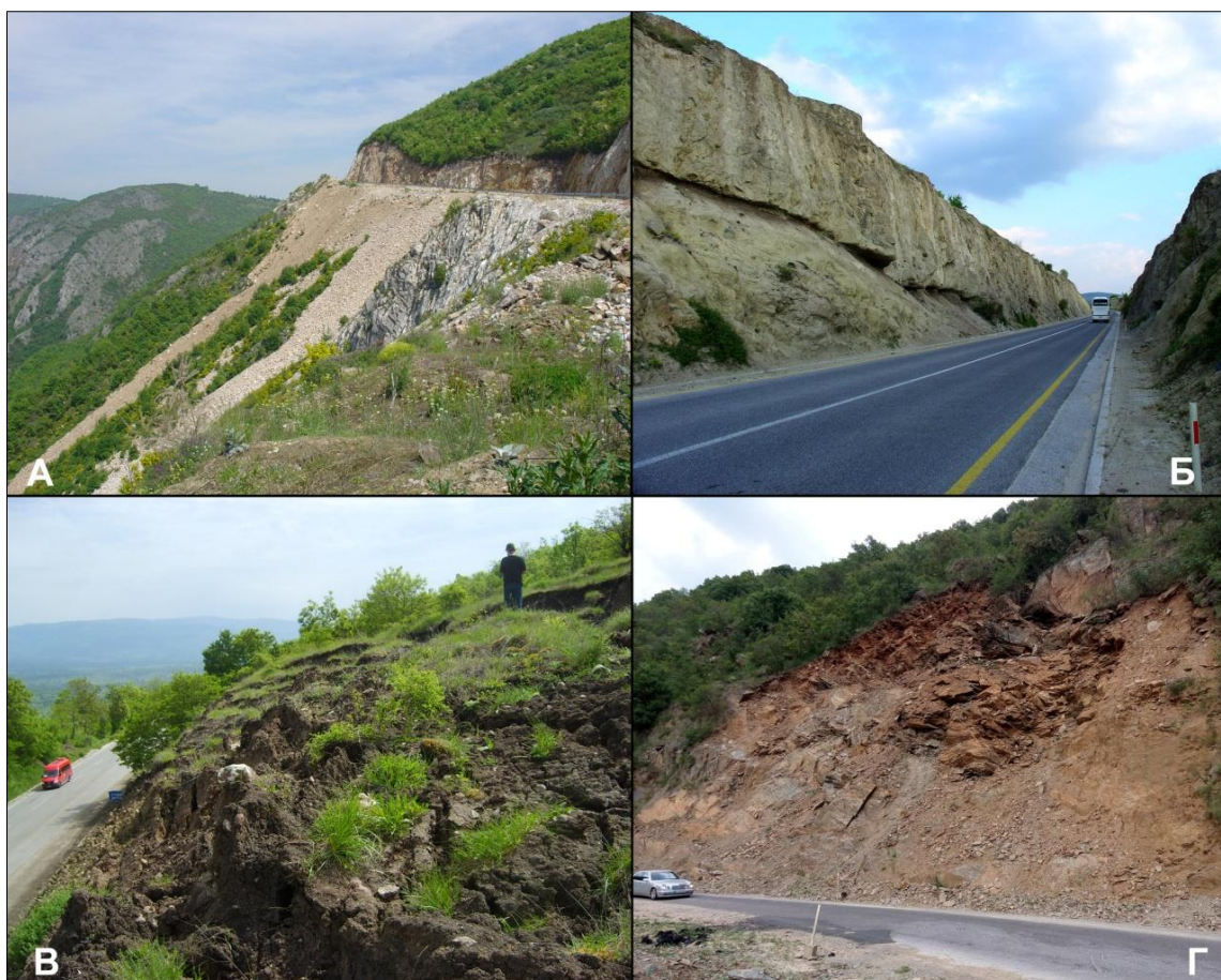
Слика 4.93. Закани врз релјефот преку изградба на патишта: А создавање на сипари и деградација на релјефот (патот кон акумулацијата „Св. Петка“); Б создавање на специфични форми во туфови на засеци по должината на патот Куманово – Крива Паланка; В активирање на свлечишта на засеци кај с. Страцин; Г активирање на одрони на изразито засечени шкрилци кај с. Калиманци. Фото: Милевски И.
