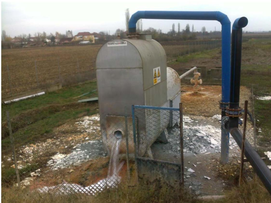
Слика бр.8 Извирање, сепарирање на сиров гас од вода-DZ<sub>1</sub> (Сопственост на ГЕЛИ)
