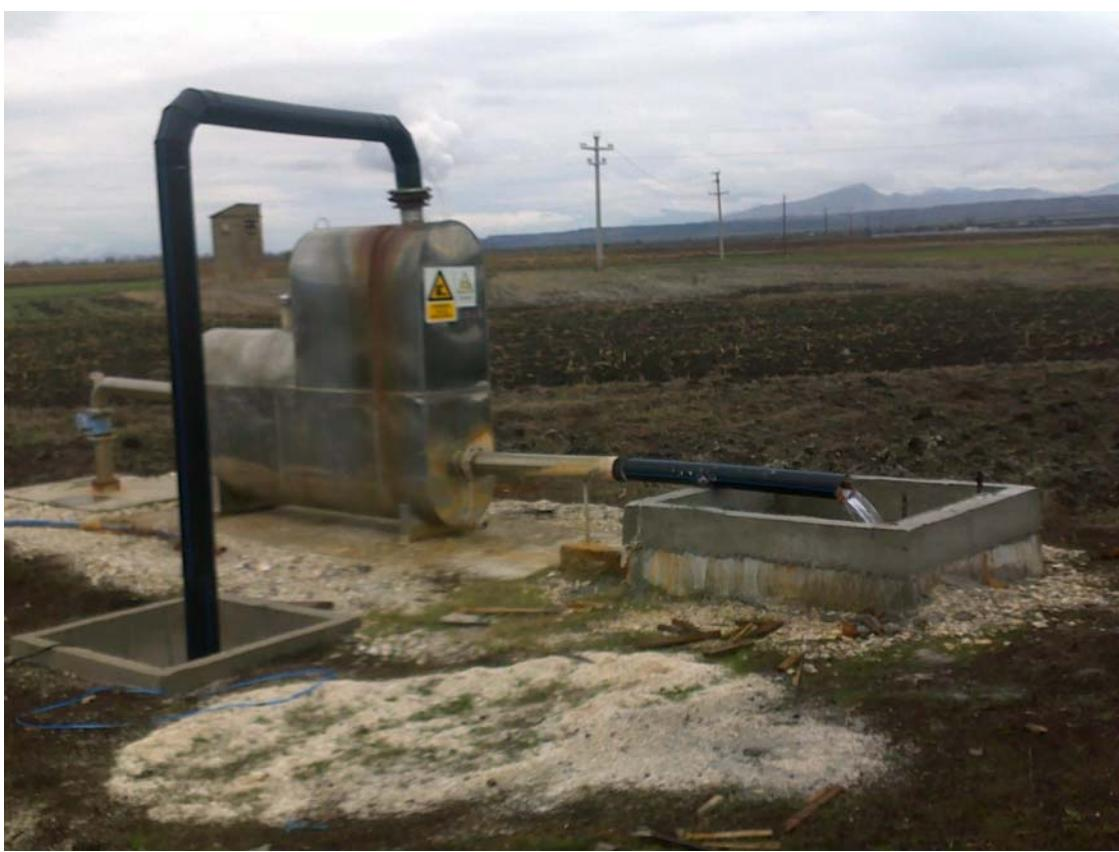
Слика бр.11 Извирање, сепарирање на сиров гас од вода-DZ<sub>4</sub> (Сопственост на ГЕОСОНДА)
