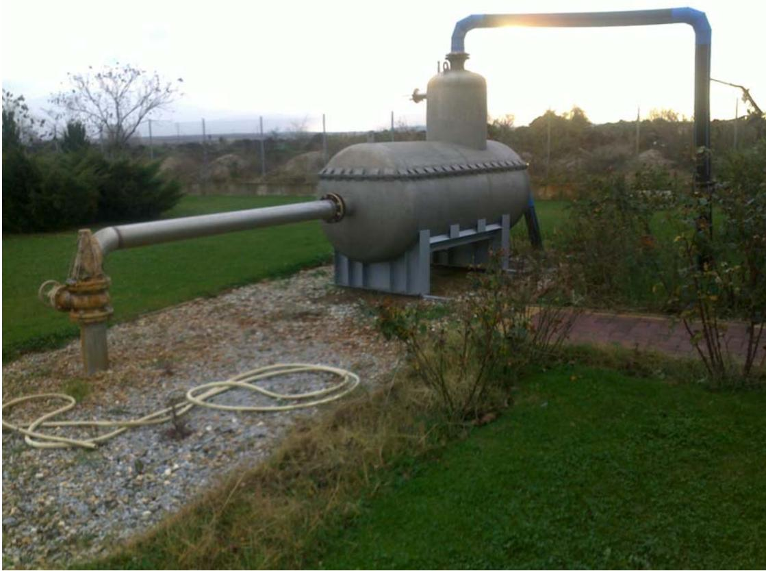
Слика бр.10 Извирање, сепарирање на сиров гас од вода-DZ<sub>3</sub> (Сопственост на ГЕОСОНДА)
