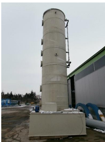
Слика 8 Изглед на скрубер и резервоар за вода
