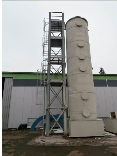
Слика 21 Скрубери за третман на гасовите од технолошката линија PHARAON 300
