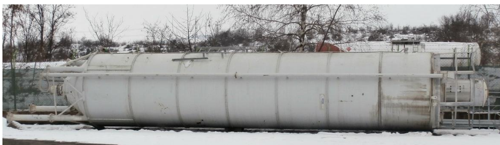
Слика 5 Изглед на силос
