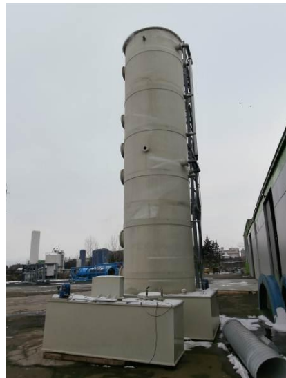
Слика 22 Резервоари за вода за скрубериот
