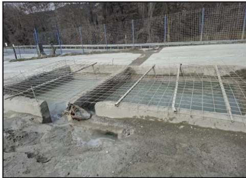
Слика II.5: Таложник за вода (база I и база II)
