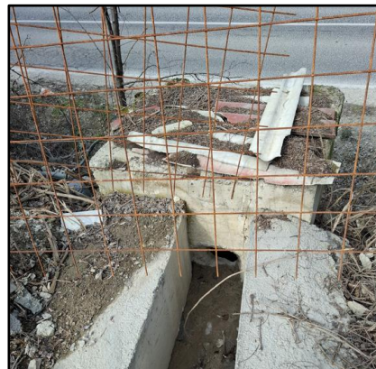
Слика бр. VII.1: Бетонирани канали за собирање на атмосферски води
