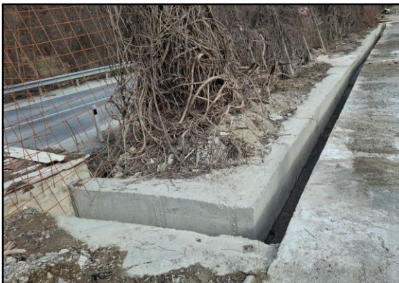
Слика бр. VII.1: Бетонирани канали за собирање на атмосферски води
