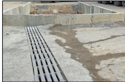
Слика II.5: Таложник за вода (база I и база II)
