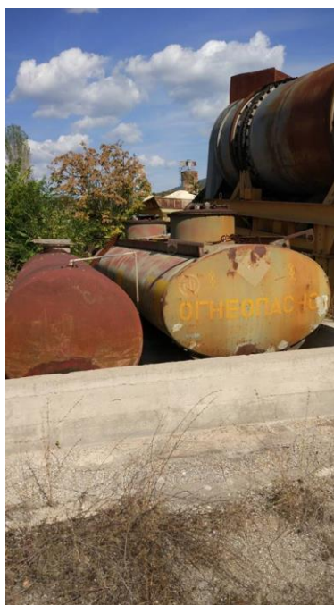
Слика бр. 5 Резервоари за битумен и екстра лесно со танквани
