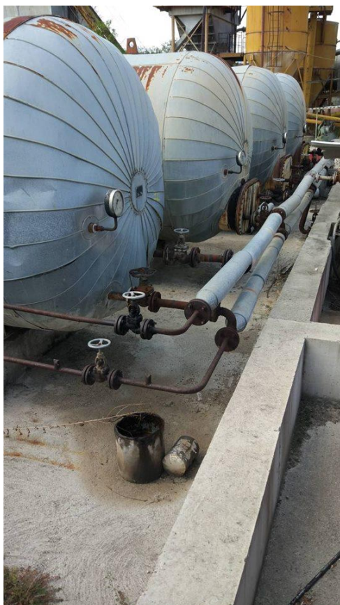
Слика бр. 5 Резервоари за битумен и екстра лесно со танквани
