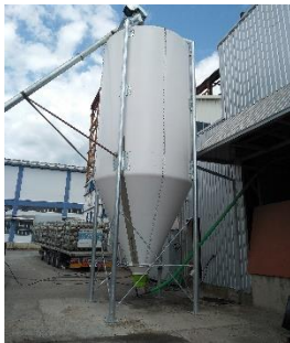
Слика 6 Резервоар за пелети и магацин за складирање на пелети во непосредна близина на котларата
