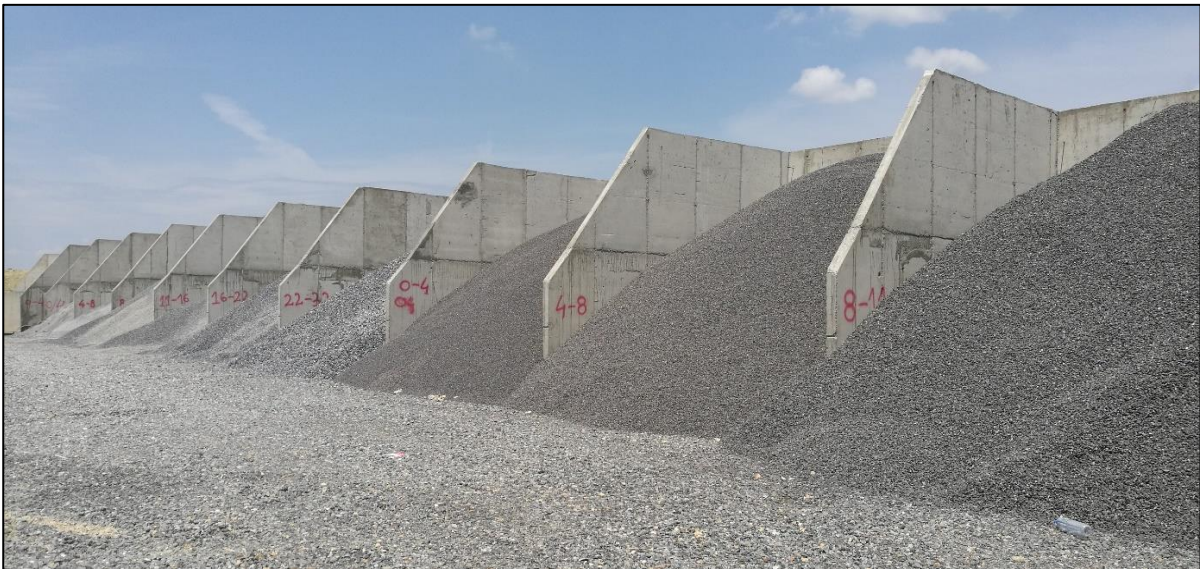
Слика II-3. Бункери за складирање на агрегат
