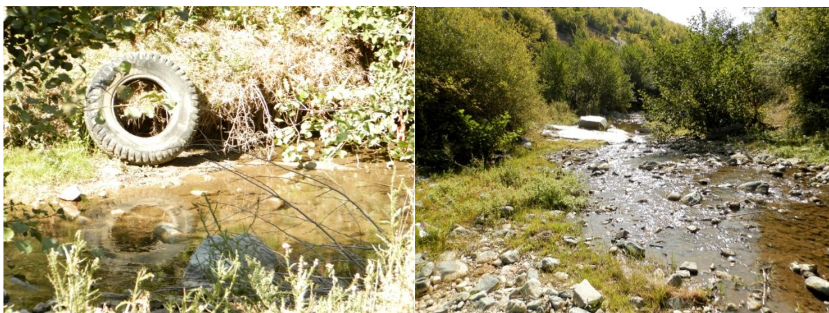
Слика 19. Поглед на сегашната состојбата на речното корито на Слупчанска река
