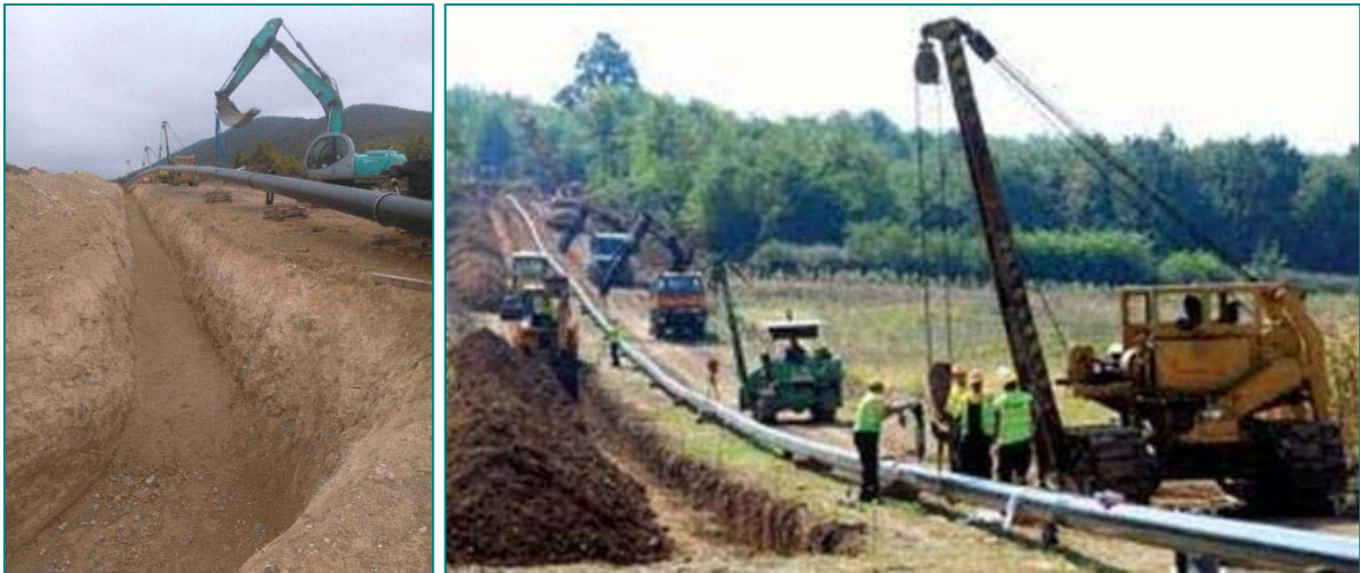
Слики бр.2 и бр.3: Дел од постапката за изведба на гасовод (спуштање и полагање на цевното црево)
