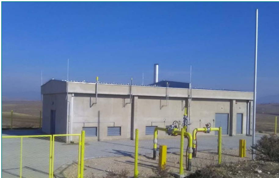
Слика бр.4: Изглед на ГМРС
