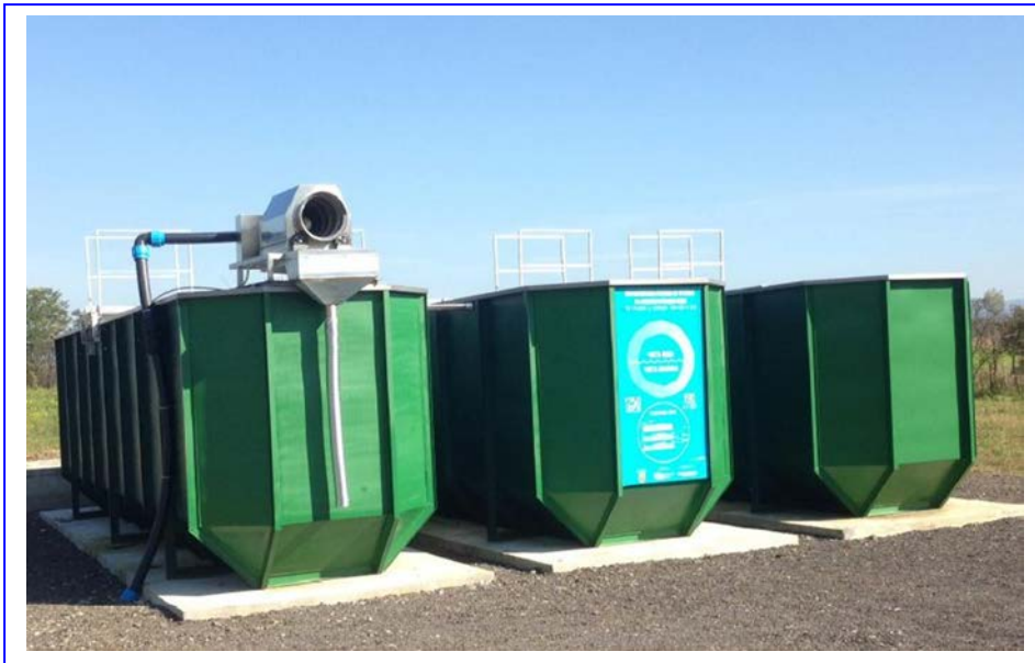
Слика бр.ИИ-35: Пречистителна станица за санитарни отпадни води
