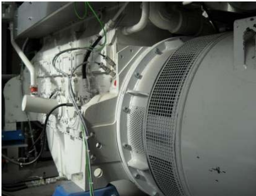
Слика 41 Мотор на биогазот + алтернатор ПСОВ Нант
