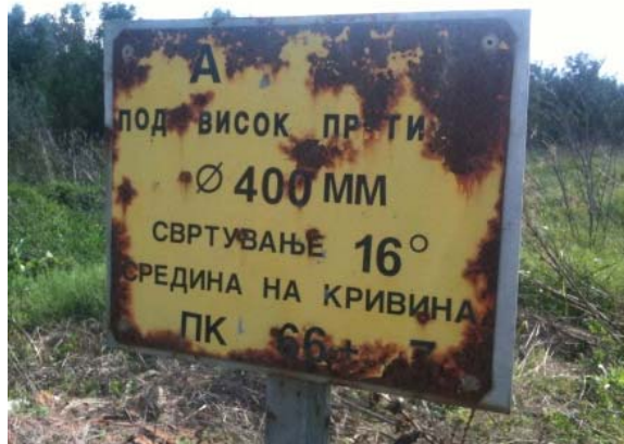
Слика 22 Табла за обележување на гасоводот на локацијата на ПСОВ
