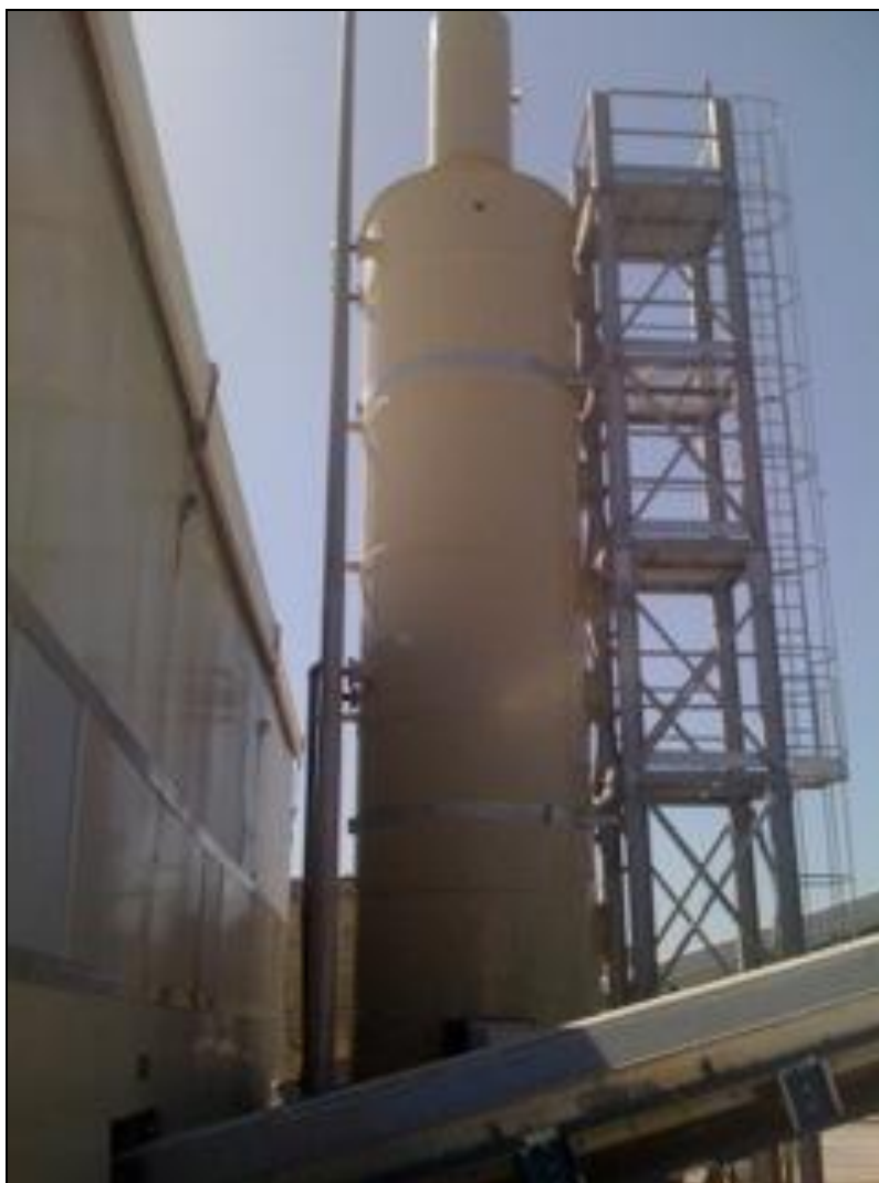
Слика 22 Изглед на предвидениот скрубера во постројката
