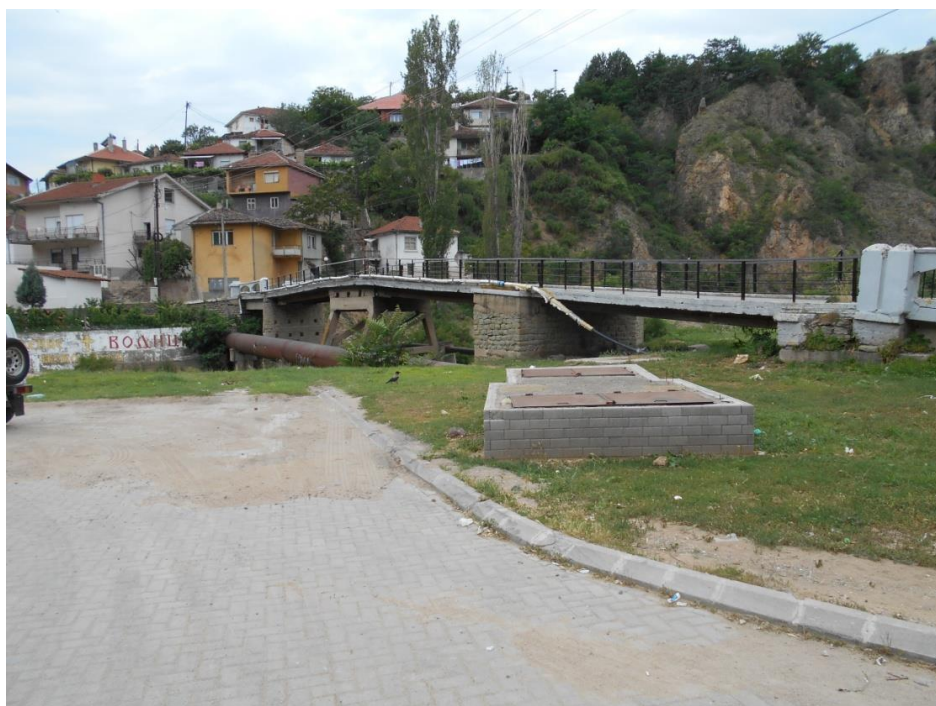
Слика 12: Локација на пумпната станица Ново Село
