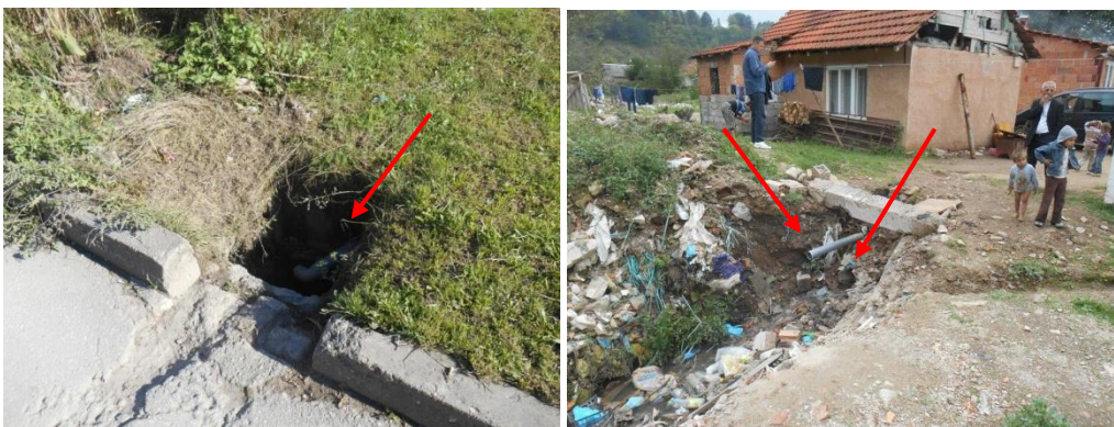
Слика 5 Канали за одведување на атмосферски води со поставени нелегални приклучоци за отпадни води
