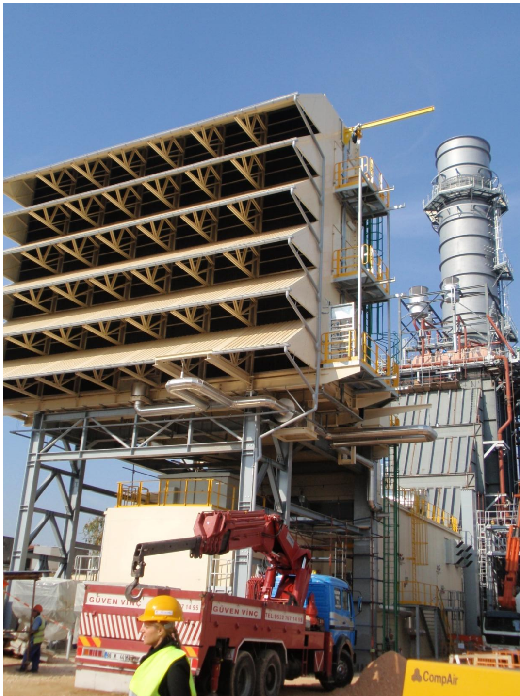
Слика 5 Филтерскиот систем за доводот на воздух во градба
