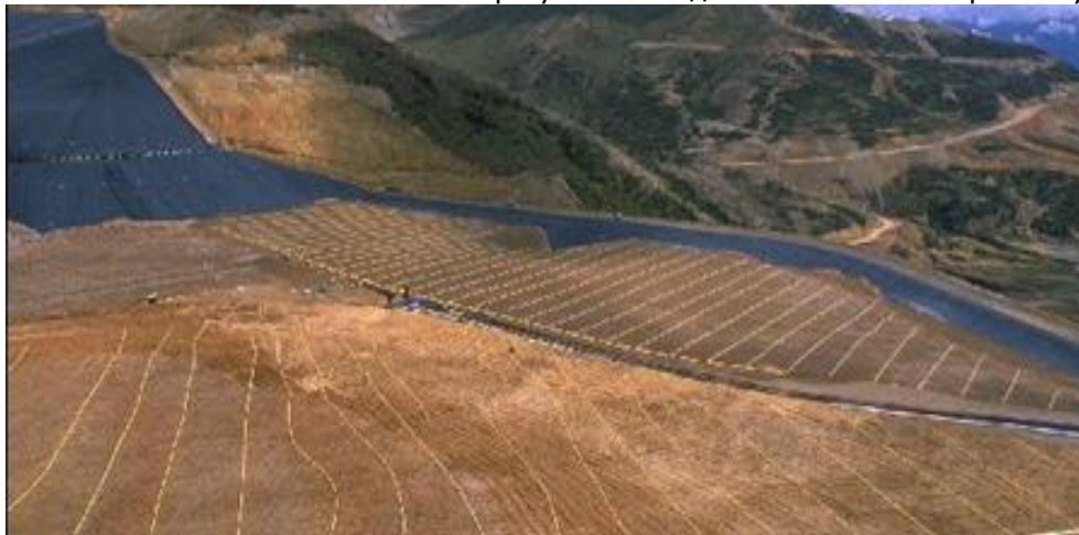
Слика 2-11 – Типичен систем на напскување на одлагалиште на минерална суровина
