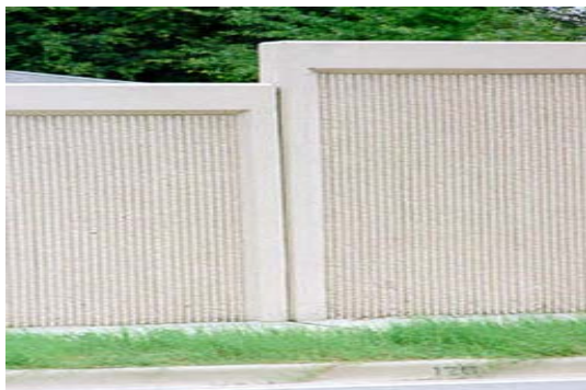
Слика 1. Бетонски звучен ѕид
