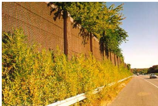
Слика 2. Бетонски звучен ѕид
