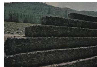
Фото 81. Габционите може да бидат наредени на различни начини заради изградба на сид
