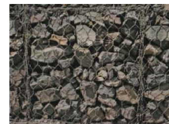
Фото 80. Габционите се во главно жичани корпи исполнети со камења
