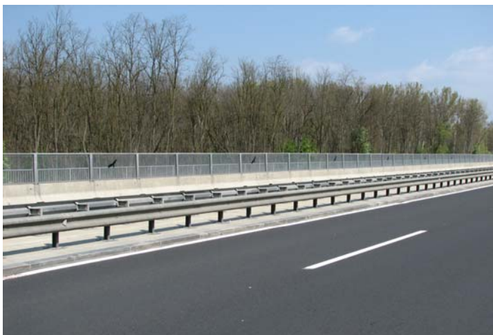
Фото 75. Заштитна ограда за заштита од убивање на птиците за време на оперирањето на автопатот
