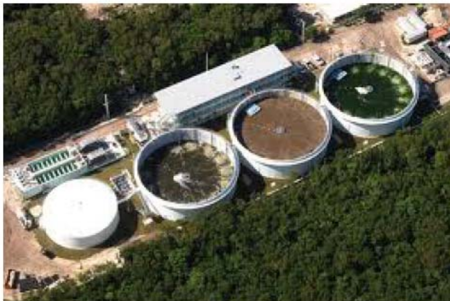
Сл. 2 Постројка (SBR)
