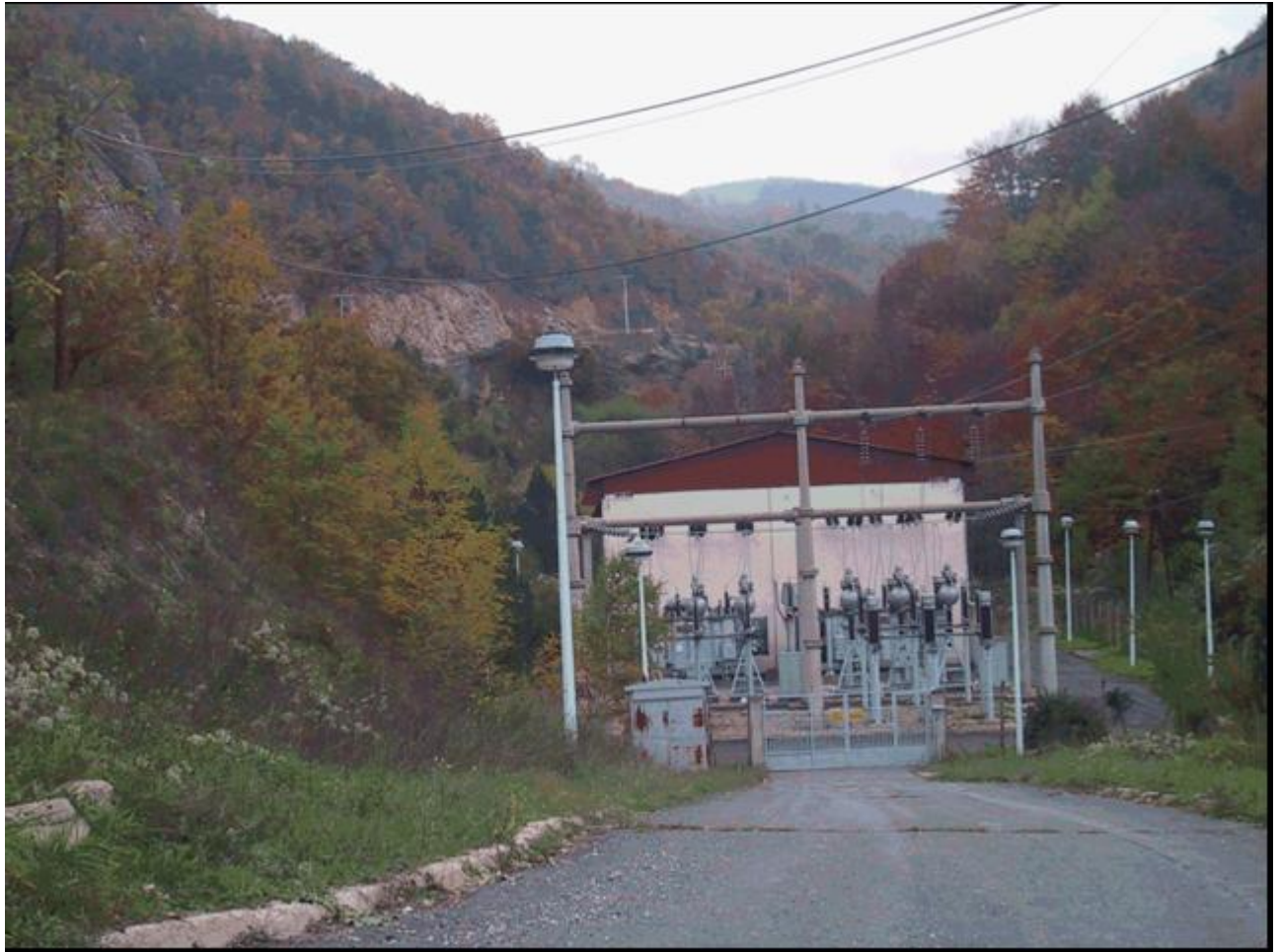
Фотографија 1: Поглед на трансформаторската станица на рудникот ‘Ржаново
