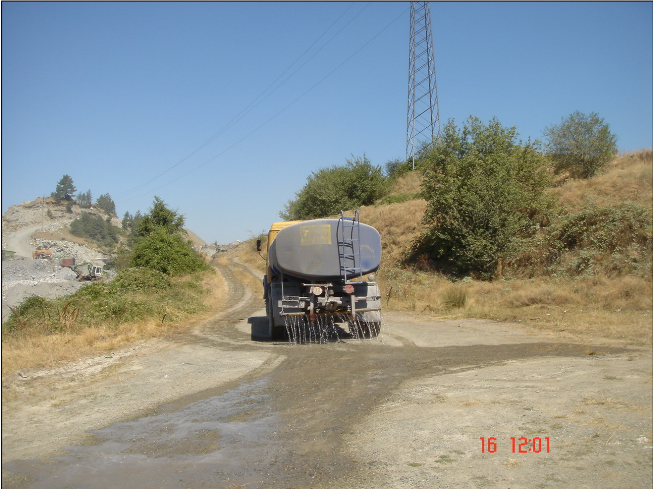
Фотографија 4: Прскање со вода на копот
