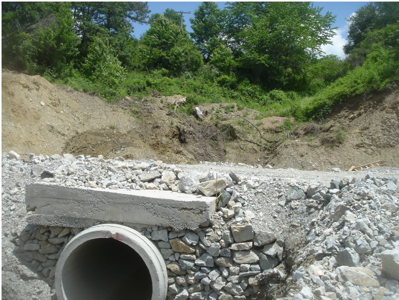
Фотографија 5: Бетонски цевковод низ новиот пат до одлагалиштето за јаловина
