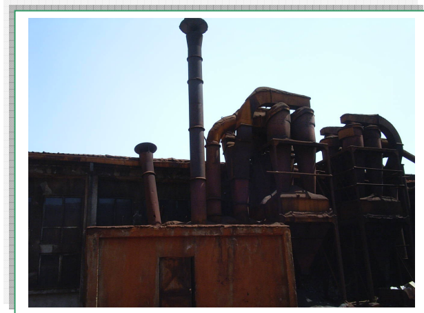
Слика бр. 21: Испуст од систем за отпашување од пескара К4
