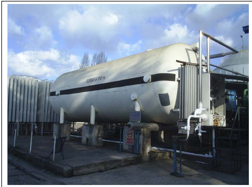
Слика бр. V-3 : Резервоар за \text{N}_2
