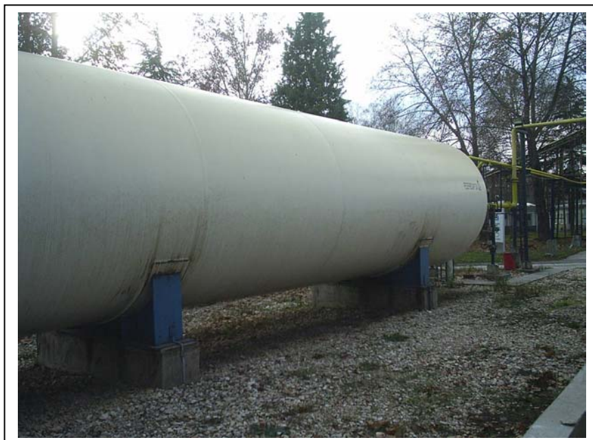
Слика бр. V-4 : Резервоар за \text{O}_2
