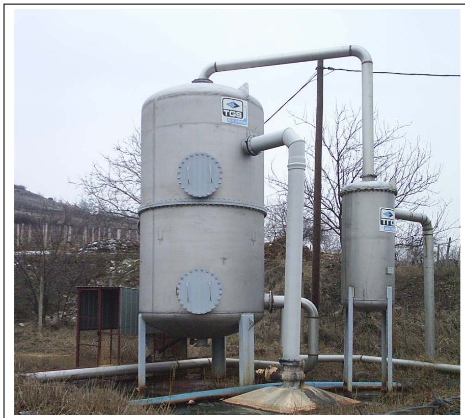
Слика бр. V-1 : Сепаратор на Долна бушотина
