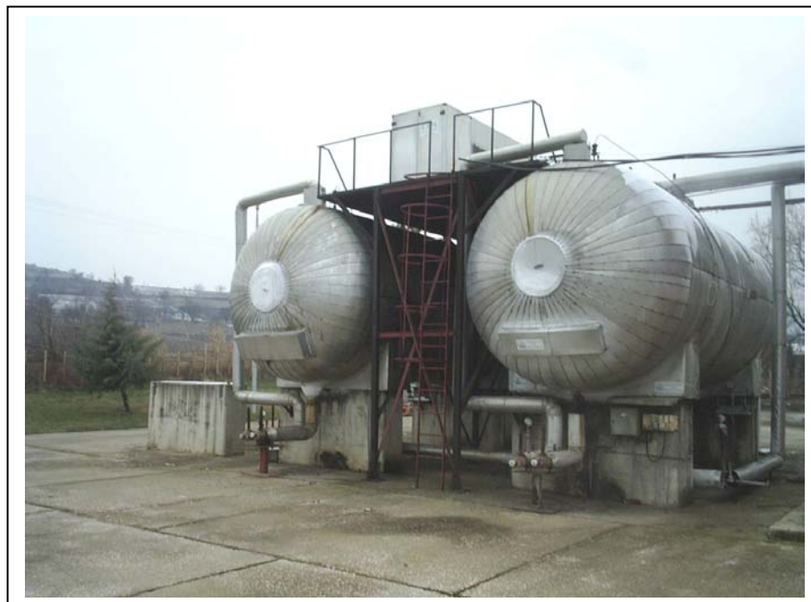
Слика бр. V-3 : Резервоари за складирање на течен \text{CO}_2
