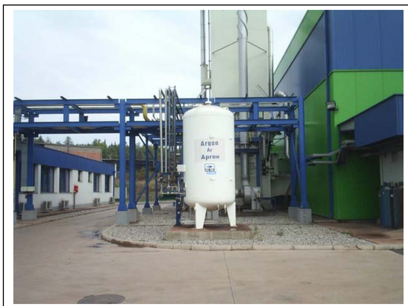
Слика бр. V-7 :Резервоар за Ar
