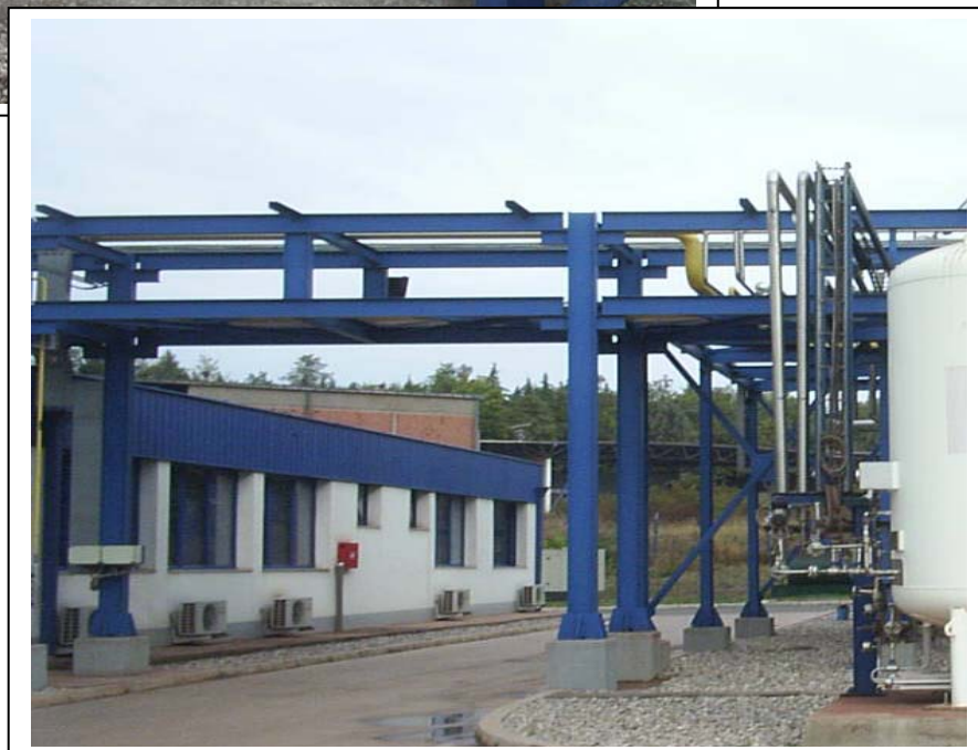
Слики бр. V-1 и V-2 : Дел од цевната инсталација и цевниот мост
