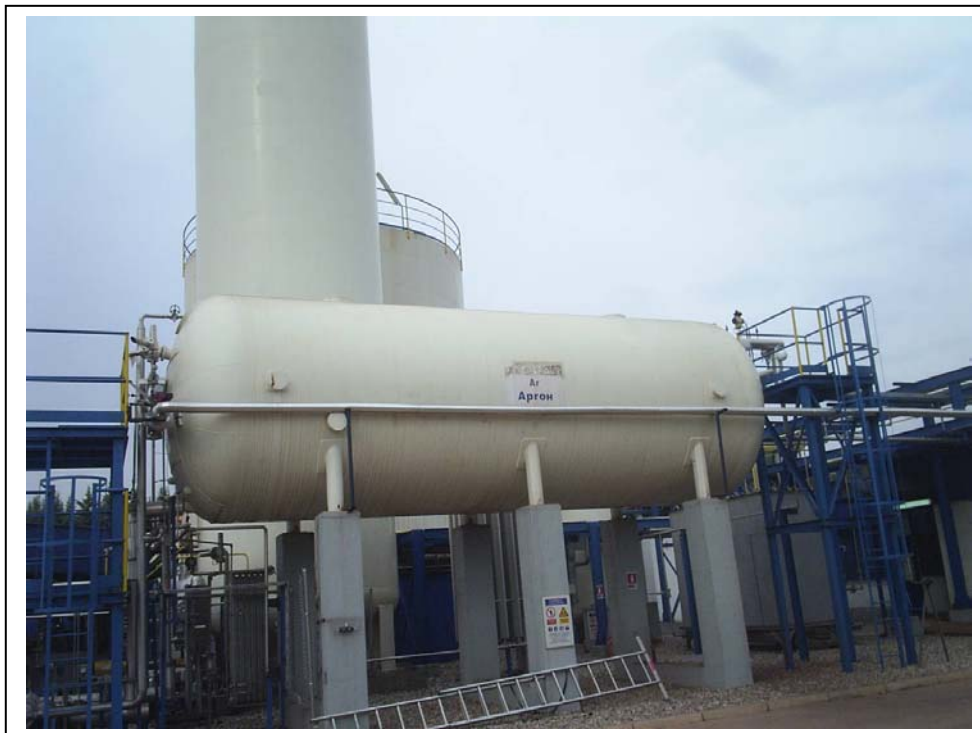
Слика бр. V-8 :Резервоар за Ar
