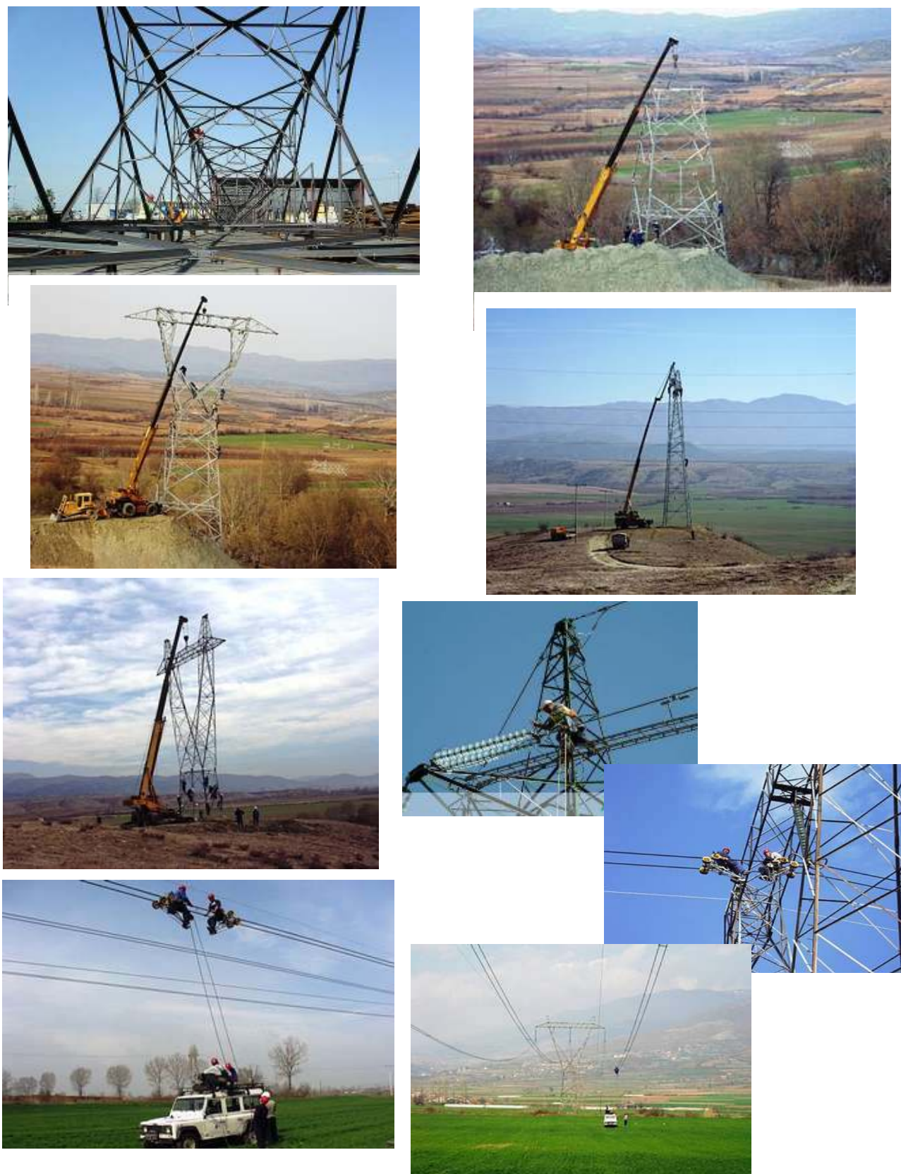
Слика 2-3 — Изградба и инсталација на 400 kV далекувод
