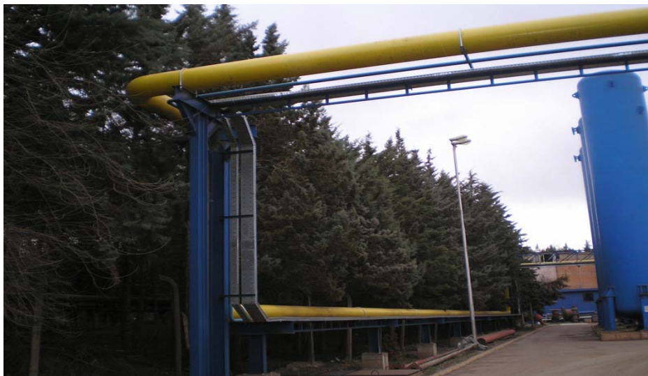
Слики бр. V-1 и V-2 : Дел од цевната инсталација и цевниот мост
