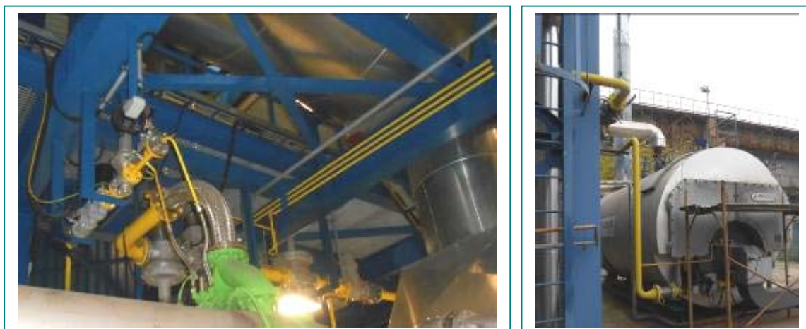
Слики бр.V-2 и бр.V-3: Цевни инсталации (обоени жолто) за снабдување со природен гас во и надвор од објектот
