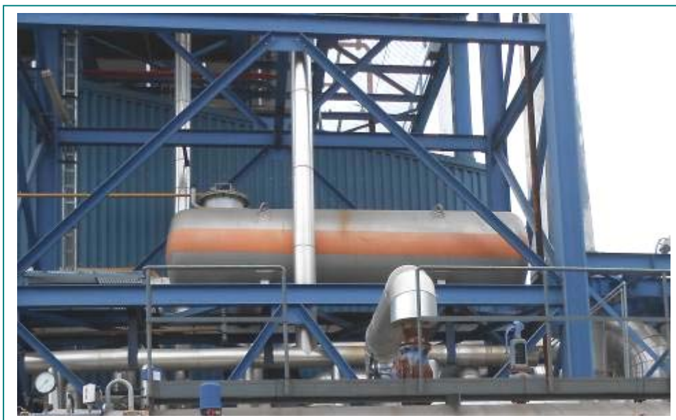
Слика бр.V-6: Резервоар за масло за подмачкување на гасните мотори
