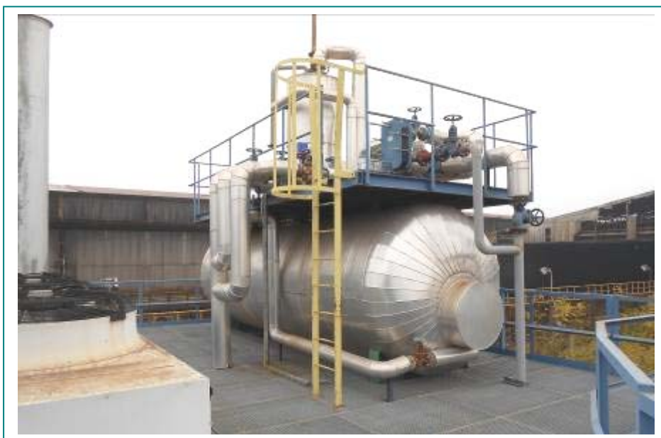
Слика бр.V-5: Напоен резервоар за ДМ вода со деаратор
