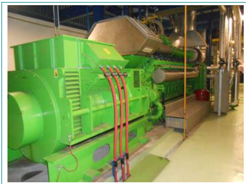
Слика бр.ИИ-5: Когенеративна постројка JMS 620 GS-N.LC
