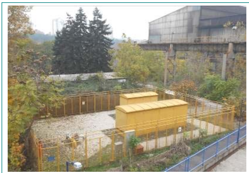
Слика бр.V-1: Мерно регулациона станица за природен гас
