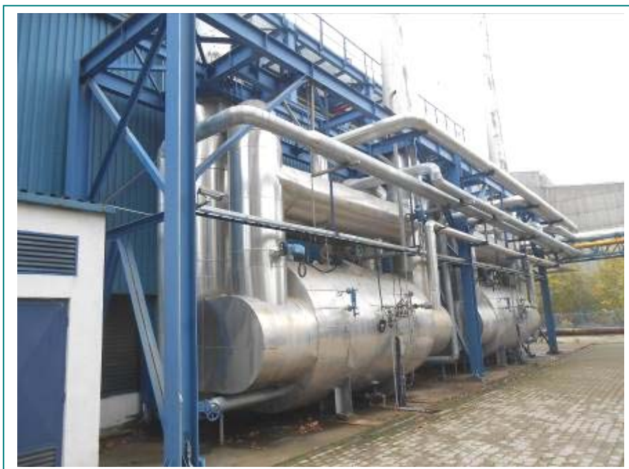
Слика бр. II-6: Генератори на пара поставени на јужната страна од објектот
