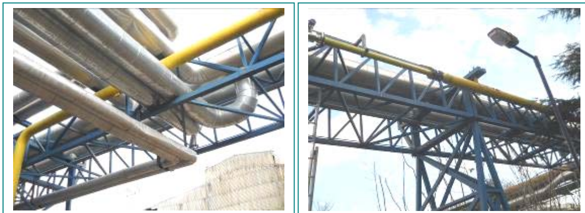
Слики бр.V-7 и бр.V-8 : Надземни надворешни цевководи за технолошка пареа и топла вода
