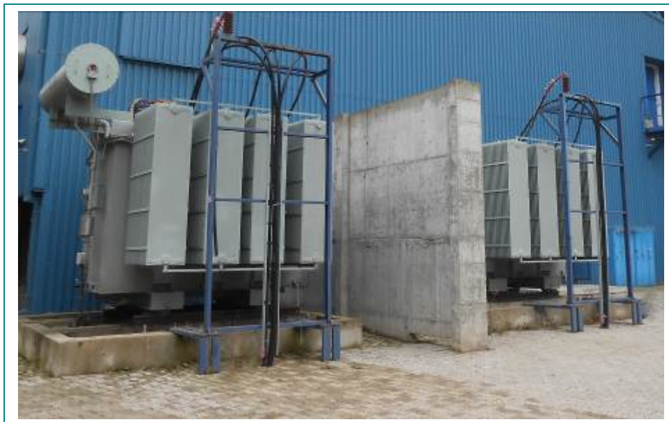
Слика бр. II-9: Трансформатори 35/10 kV
