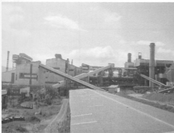
Слика бр. 9: Тракаст транспортер за дотур на материјал од Бункерите за складирање до ротационите печки
