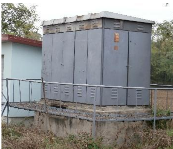
Слика 1 Трафостаница за обезбедување електрична енергија
