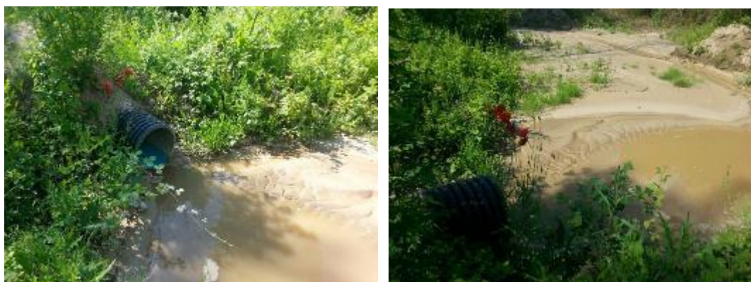
Слика 15 Земјен таложник
