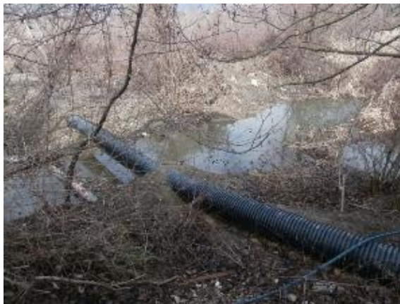
Слика 14 Цевка за одведување на отпадните води во земјен таложник
