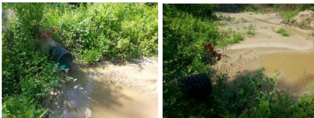
Слика 8 Точка на испуст на отпадните води од бетонскиот во земјениот таложник
