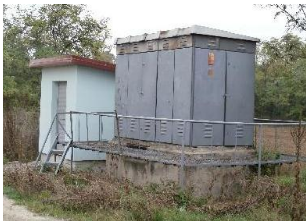
Слика 9 Трафостаница и разделна станица за струја
