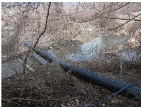
Слика 7 Цевка за одведување на отпадните води во земјен таложник
