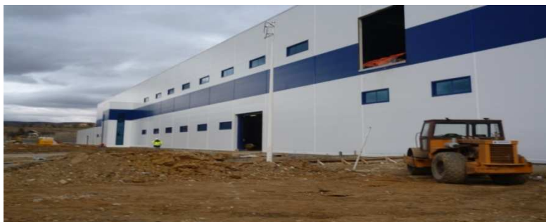
Слика 2.4 – Поглед на новата производна хала од запад кон исток
