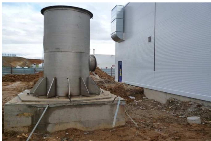
Слика 2.10 – Приказ на првиот инсталиран сегмент на оџакот за Линија 3 со бетонскиот темел
