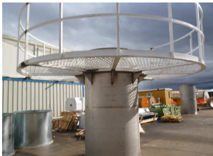
Слика 2.11 – Приказ на сегментот од оцакот со заварена пристапна платформа за вршење на мерења на емисија на полутанти во атмосфера
