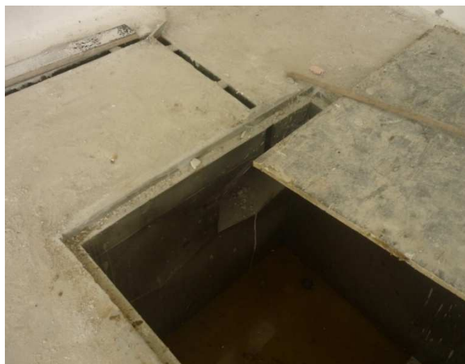
Слика 2.16 – Приказ на собирниот канал и собирната јама во една од просториите
