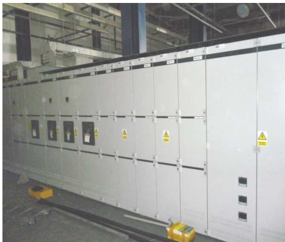
Слика 2.23 – Дел од нисконапонските дистрибутивни панели во Електричната соба
