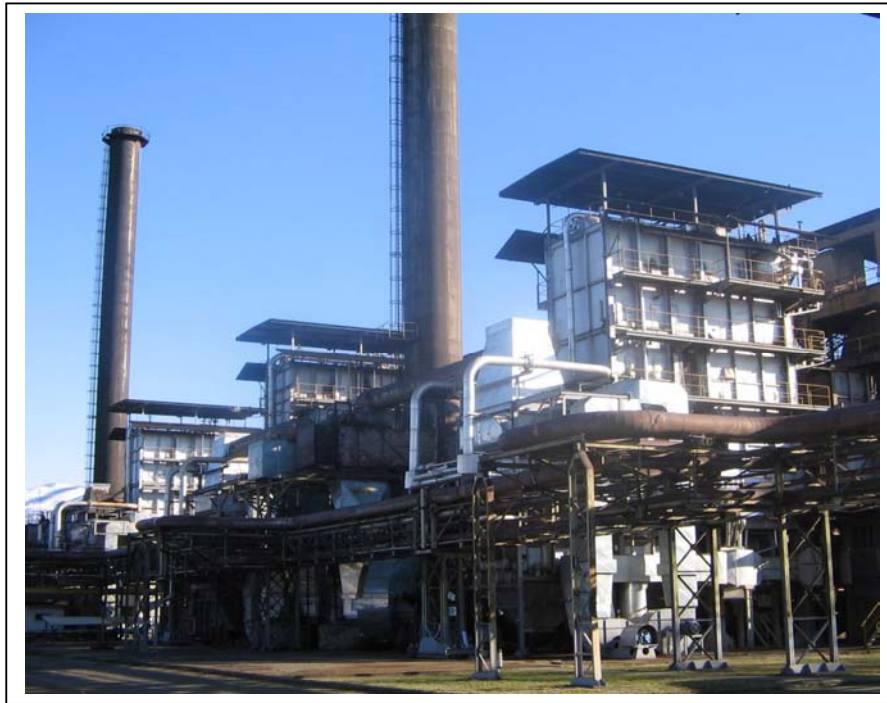
Слика бр. II-2: Три парни котли и два испуста во ЕЛЕМ Енергетика
