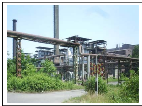
Слики бр. V-1 и V-2: Внатрешен и надворешен развод на пареа, кондензат, ДМ вода и топла вода
