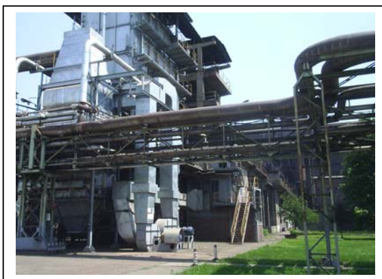
Слики бр. V-1 и V-2: Внатрешен и надворешен развод на пареа, кондензат, ДМ вода и топла вода
