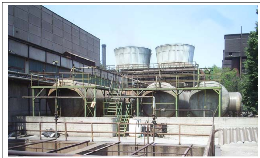
Слика бр. V-3: Склад за течни хемикалии
