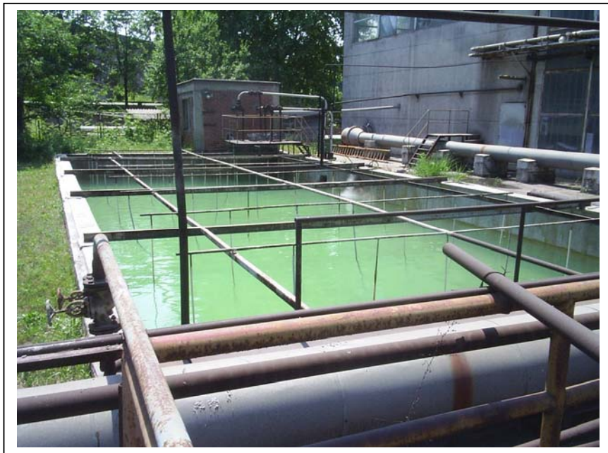
Слика бр. II-6: Базени за неутрализација на отпадна вода во ХПВ
