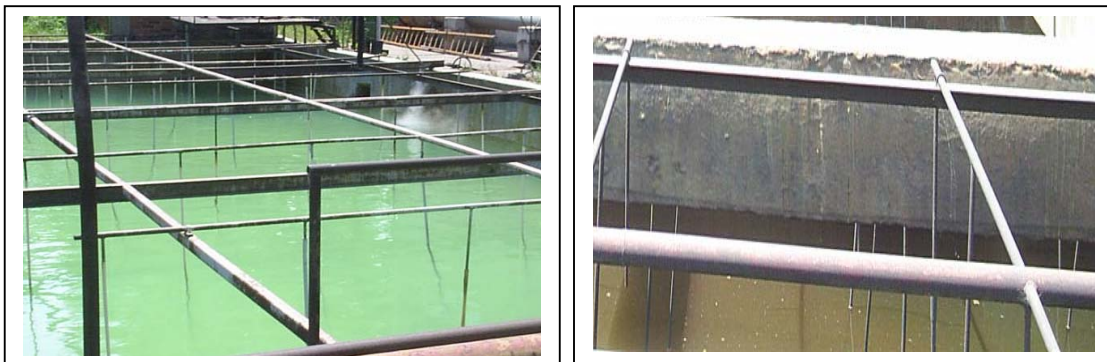
Слики бр. V-6 и бр. V-7: Инсталација за компримиран воздух за мешање на отпадната вода при неутрализација
