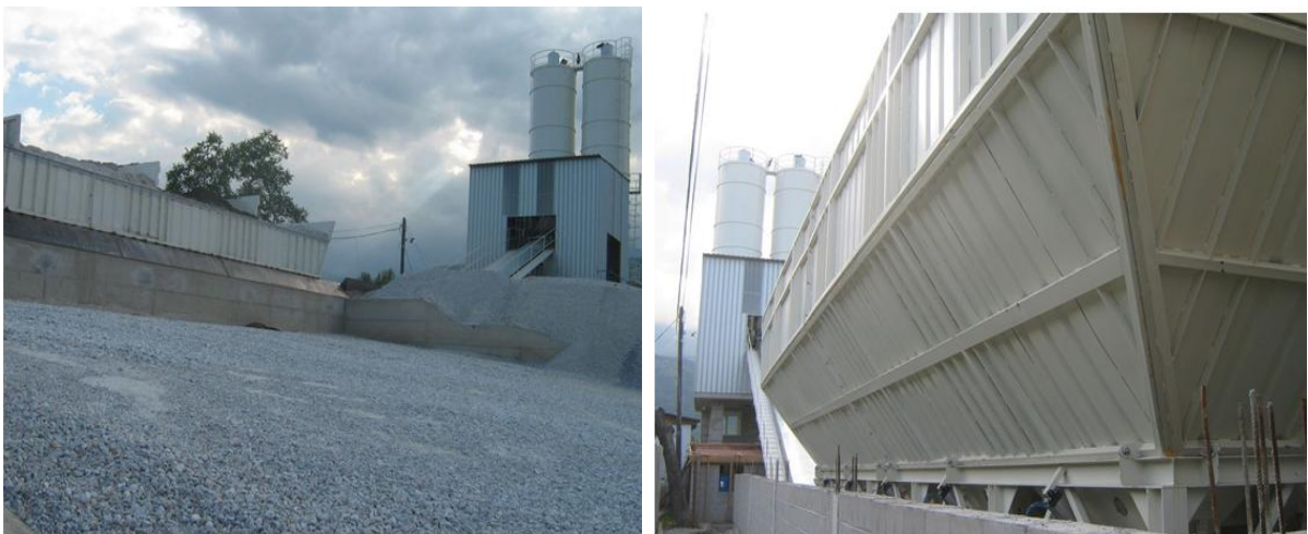
Слика 1 и 2 Силоси и боксови за складирање на суровини (агрегат и цемент)
