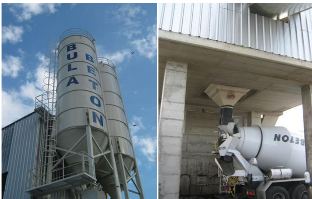
Слика 3 и 4 Поглед на опишаните силоси за цемент и утовар на готовиот производ-бетонската смеса во миксерите за испорака до купувачот
