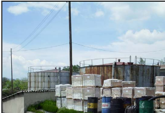
Слика 21: Надземни резервоари за складирање на мазут
