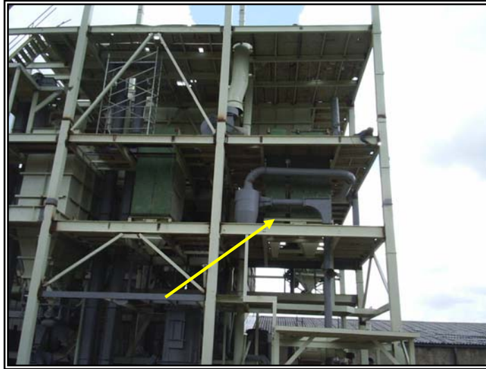
Слика 22: Филтерска постројка за отстранување во новиот погон
