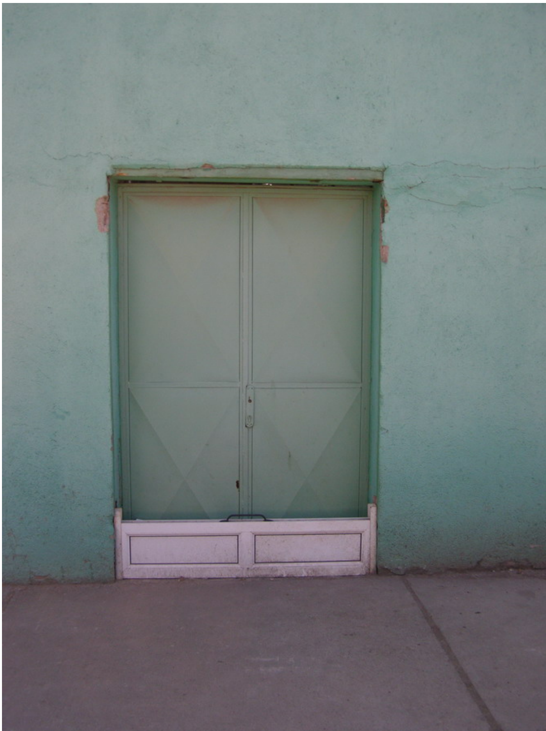
Слика 12.3 Бариери за заштита од истекувања
