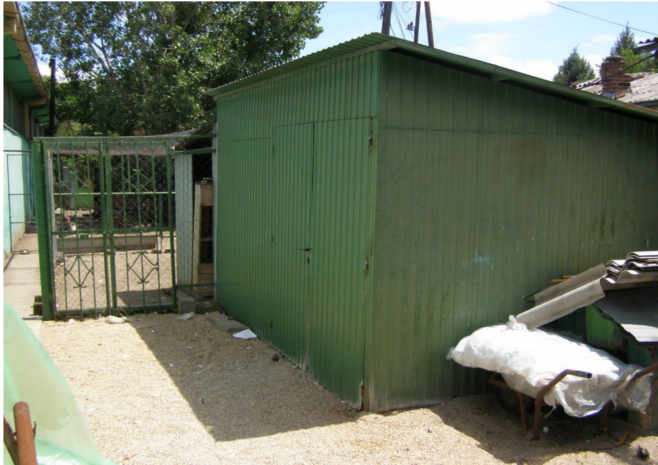
Слика бр.2 Склад за цврст отпад
