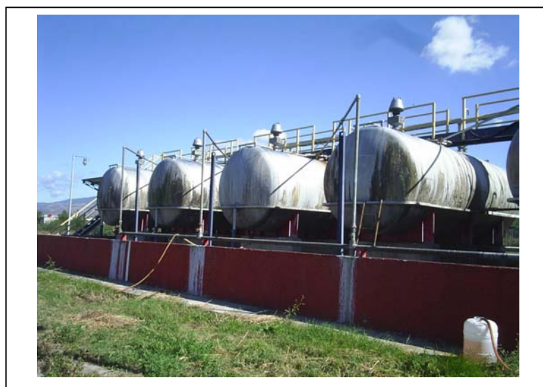
Слика бр.6: Резервоари за складирање на запаливи течности
