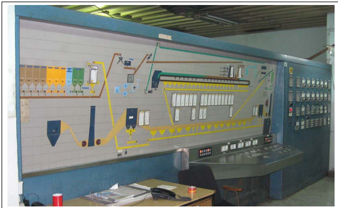
Слика бр. II-3 : Команден пулт во погонот Агломерација
