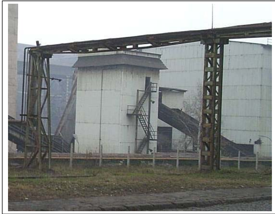
Слика бр. V-17: Надземен цевовод
