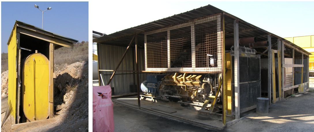
Слика 9. Резервоар за нафта и генератор за струја
