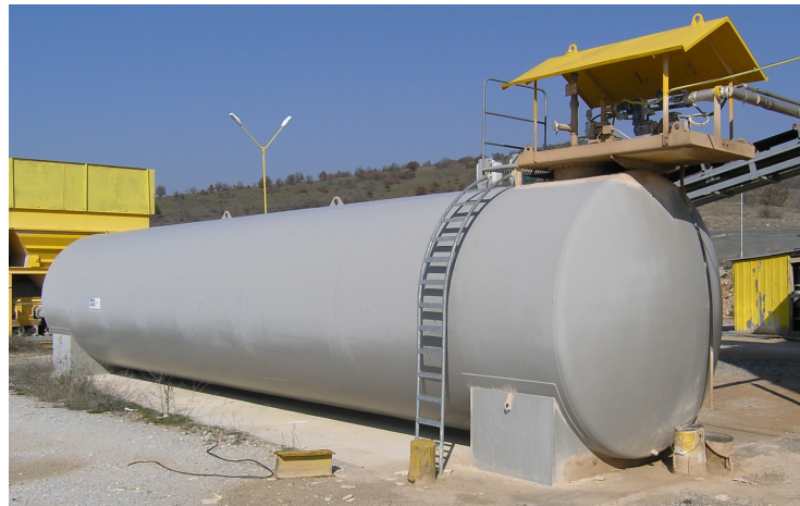
Слика 8. Резервоар за нафта
